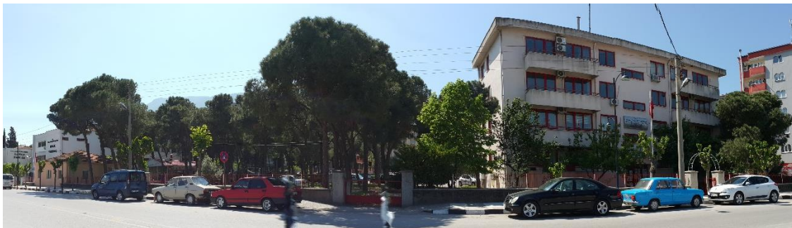
Yürürlükteki İmar Planında Pazar Alanı Olarak Belirlenen Alandan Görünüm
