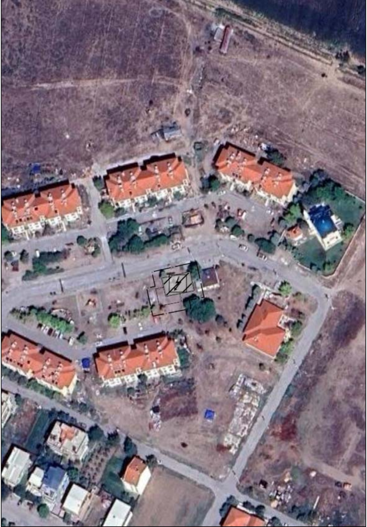
-Trafo Alanının Uydu Görüntüsündeki Konumu-
