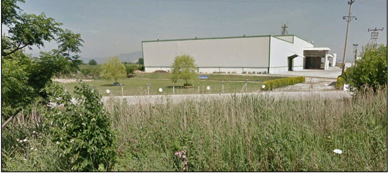
2197 nolu parseldeki tesis fotoğrafı
