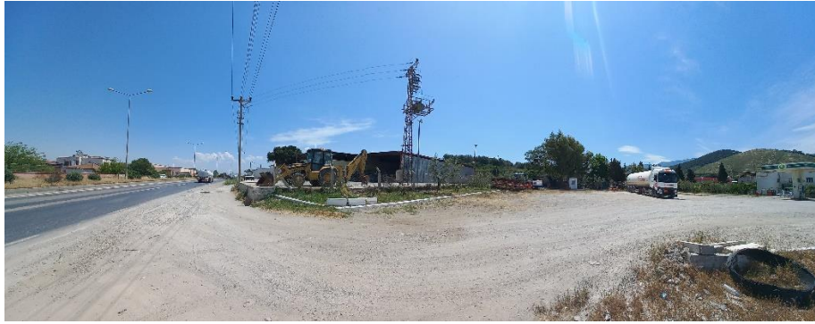
Planlama Alanı ve Akaryakıt İstasyonu Alanından Görünüm
