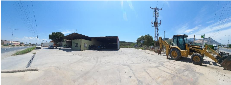
Planlama Alanının Batı Sınırından Görünüm
