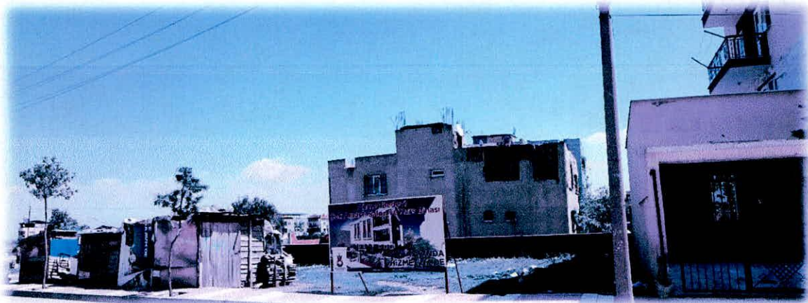
Taşınmazın Mevcut Durumundan Görünüm
