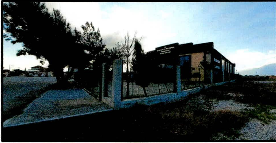
Ada:139 Parsel:2 Numaralı Taşınmazdan Görünüm
