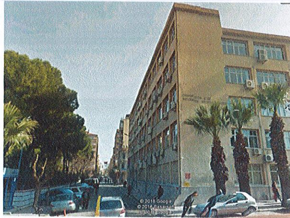
Ada:652 Parsel:24 numaralı taşınmazın 1109 sokaktan görünümü
