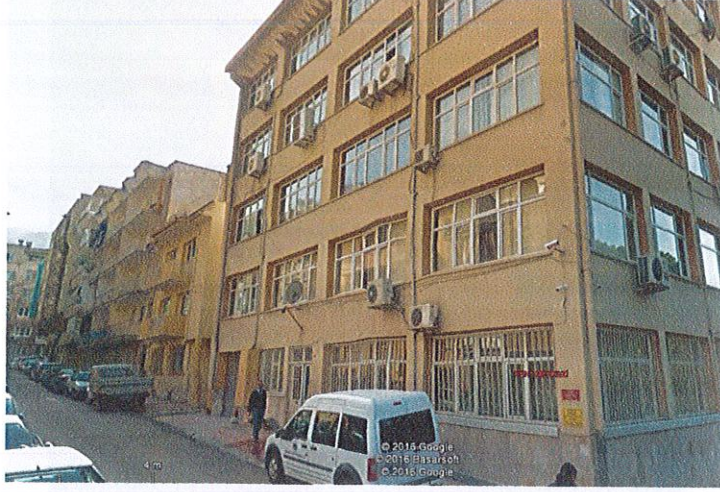
Ada:652 Parsel:24 numaralı taşınmazın 1102 sokaktan görünümü
