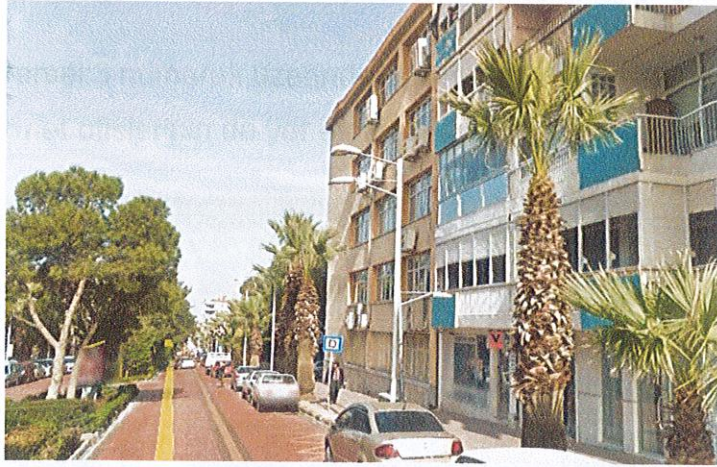
Ada:652 Parsel:24 numaralı taşınmazın Atatürk Bulvarı'ndan görünümü
