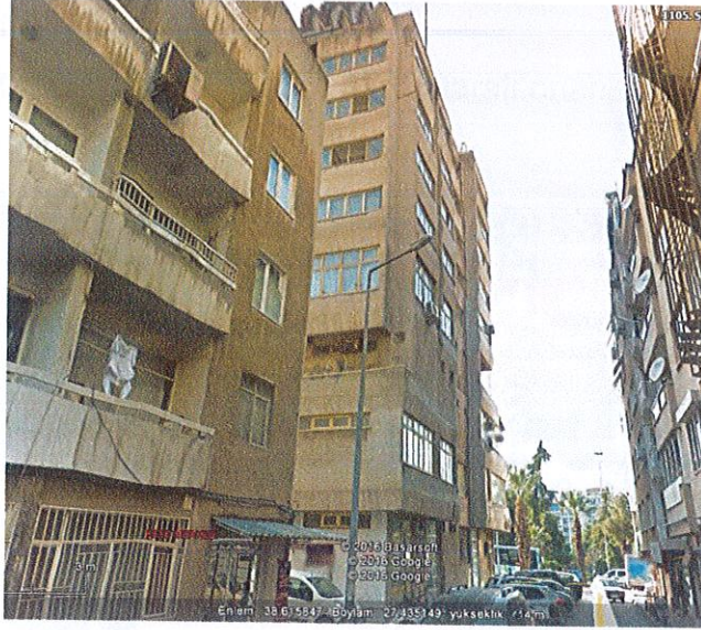
Ada:260 Parsel:3 numaralı taşınmazın 1105 Sokaktan görünümü
